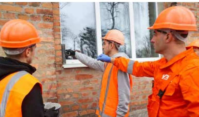
„Build back better“: Berufsschüler in Charkiw lernen, wie sie energieeffiziente Fenster in das im Krieg beschädigte Schulgebäude einbauen.
