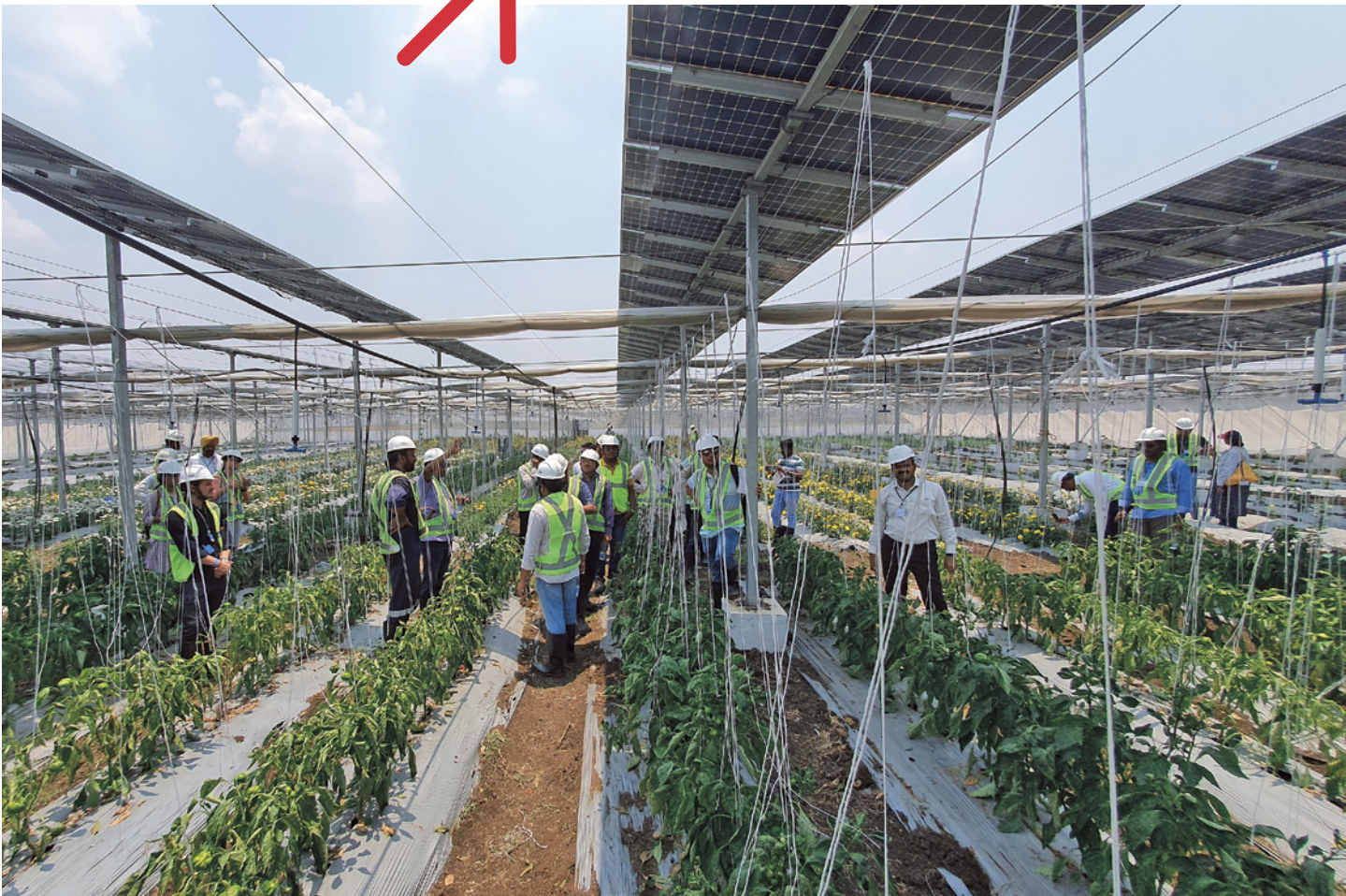
Instalación agrofotovoltaica en el Estado federado indio de Maharashtra, la cual combina el uso de la energía solar con la agricultura.
