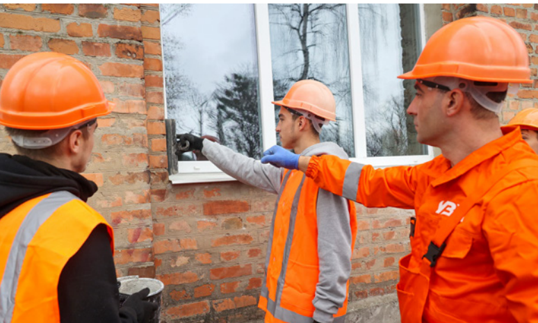
«Відбудувати краще, ніж було»: студенти професійного училища у Харкові вчаться монтувати енергоощадні вікна в будівлі училища, яка була пошкоджена через війну.
