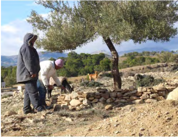
La mise en place d'une cuvette (Wafa SAIDI)
