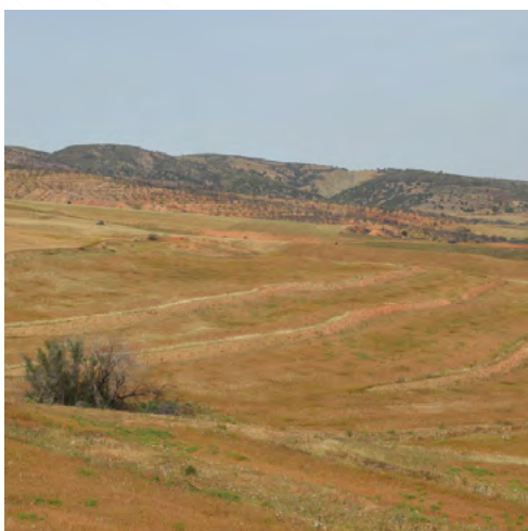
Terrain aménagé en banquettes mécaniques (Wafa SAIDI)
