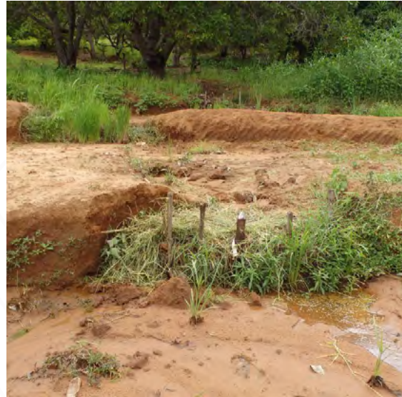
Fascines installées sur une ravine (Dimby RAHERINJATOVOARISON)
