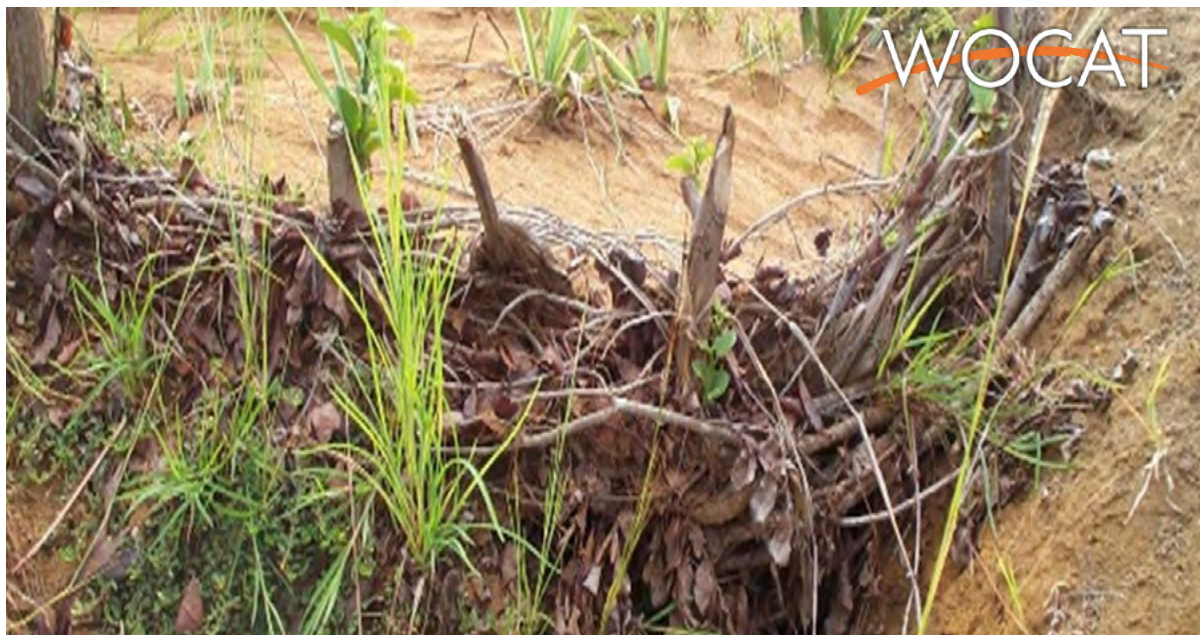
Exemple de fascine, les dépôts de sédiments en amont sont bien visibles (Solofo RAHARINAIVO)
