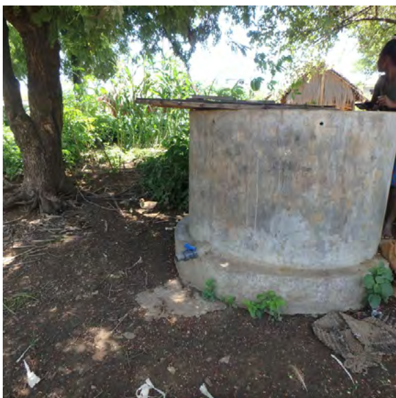
Réceptif de préparation du compost liquide (Felana Nantenaina Ramalason)
