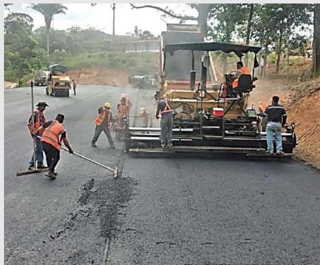
Figura 22. Fuente: Parqueo CUNIZAB. Pavimentadora y colocación de asfalto.
