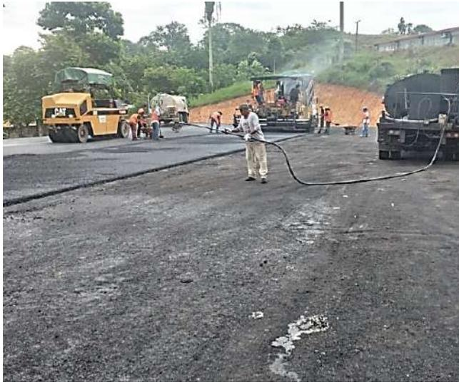
Figura 23. Fuente: Parque CUNIZAB. Aplicación del riego de liga.
