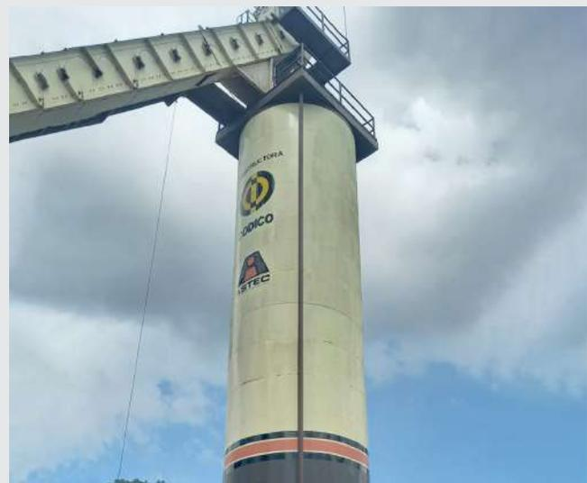
Figura 10. Fuente: Planta Codico Cayuga. Elevador y silo y almacenamiento (capacidad 200 toneladas métricas)
