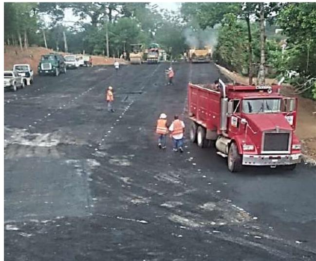
Figura 20. Fuente: Parqueo CUNIZAB. Camión de volteo para acarreo de mezcla asfáltica.
