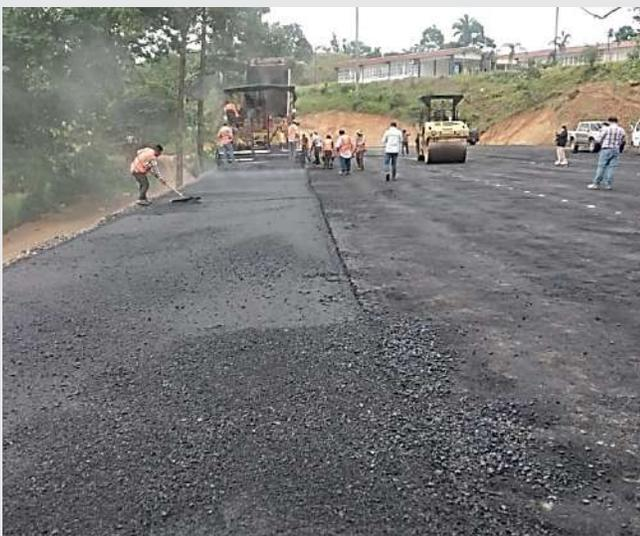
Figura 21. Fuente: Parqueo CUNIZAB. Pavimentadora y colocación de asfalto.
