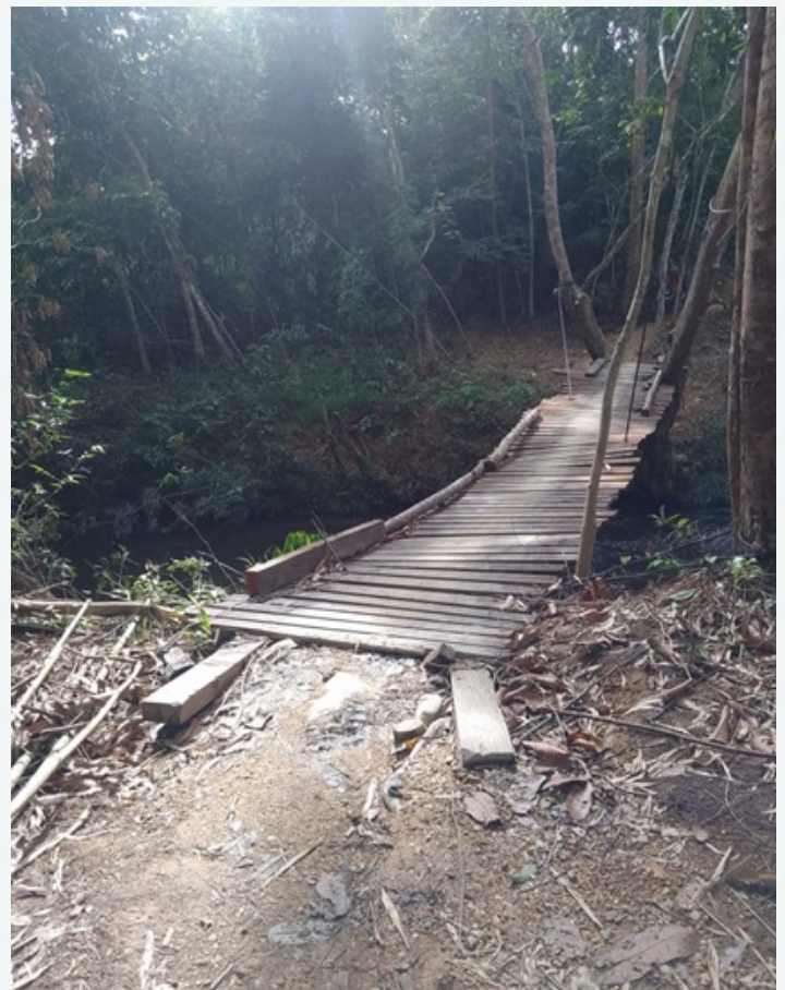
Deskripsi foto: Jembatan darurat dibangun sebagai akses sementara | Photo: ©GIZ/GRASS
