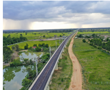
Links: Gemeinsame Projektarbeit Rechts: Blick auf die China-Laos-Eisenbahn
